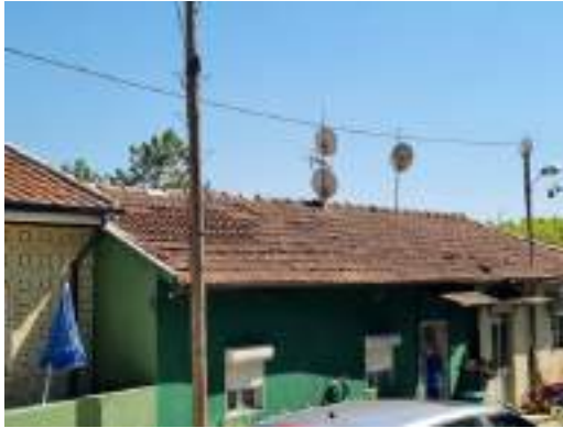
Figure 10 House n. 1 - Porto before
