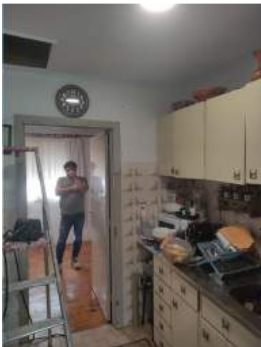
Figure 12 House n. 1 - Porto Before
